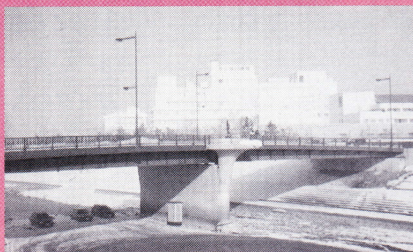
■彫刻橋として装いも新たになった緑橋(昭和63年完成)
