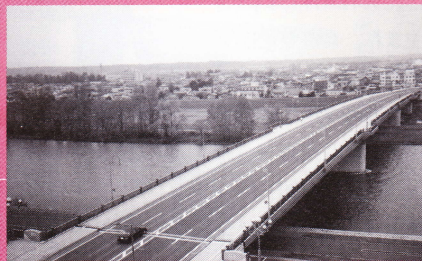
■四代目新橋(平成十四年完成)
